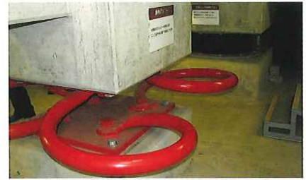
自衛消防隊訓練会（免震装置）
